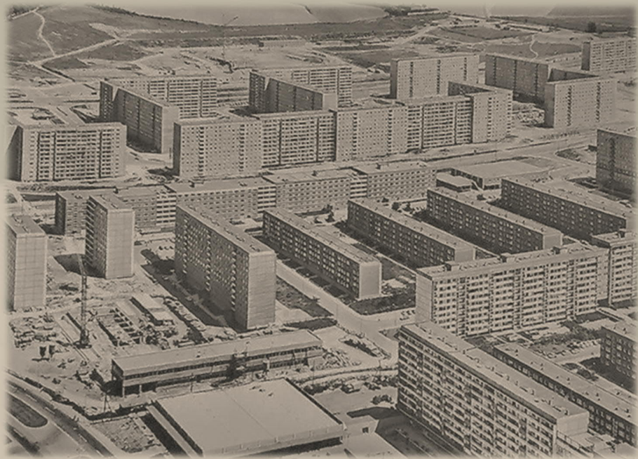
Plattenbau in aanbouw te Jena, 1968. Postkarte DDR, www.jenaer-nachrichten.de
